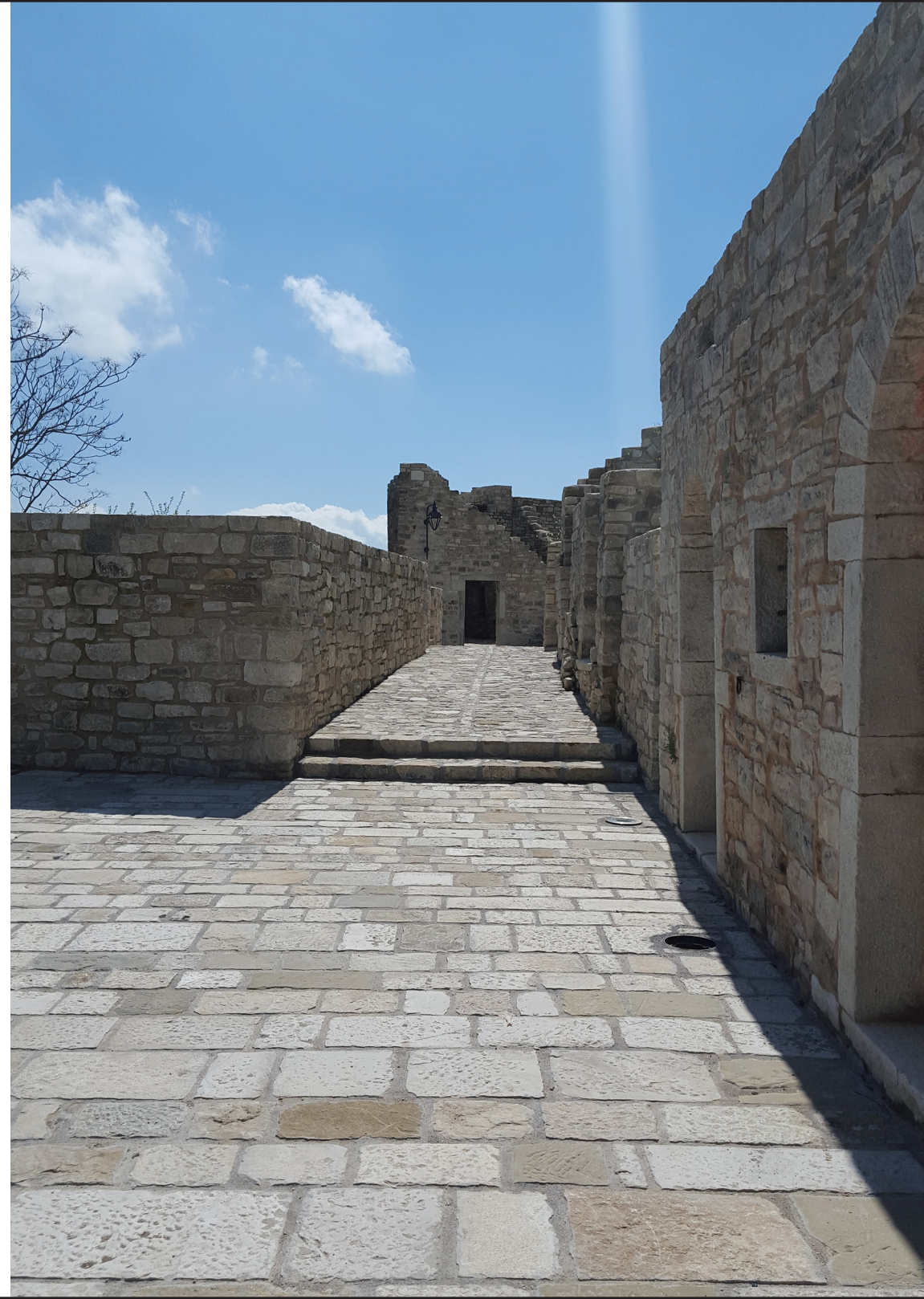
Foto del Borgo Antico di Molinara, vista attuale vico del Forno, Ufficio Tecnico Costruzioni Lombardi Achille S.R.L..
